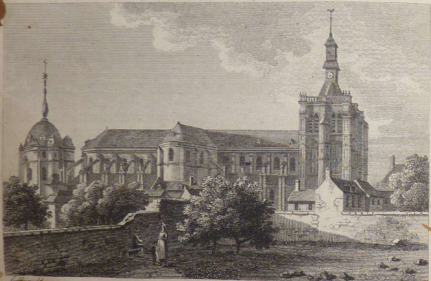
Vue de l'Eglise de S t Pierre, à Douay, Dépt du Nord.
